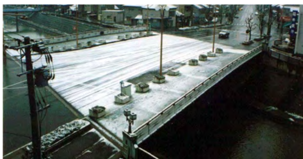
Рисунок 7-10-1. Стан замерзання мостового покриття з використанням сталевого перекриття
