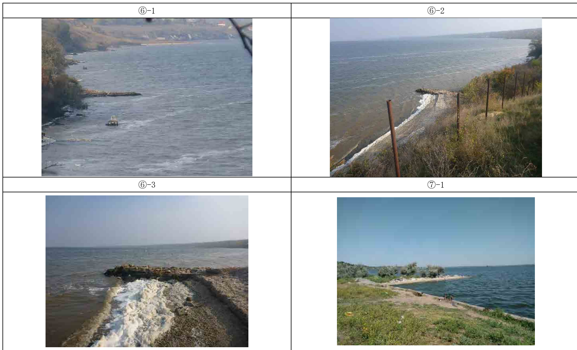
図 18-2-6. 河川構造物状況写真(3/4)
