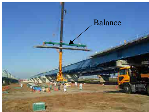
図 11-2-22. 吊上げ参考図
