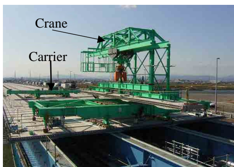
図 11-2-23. 走行クレーンによる架設参考図
