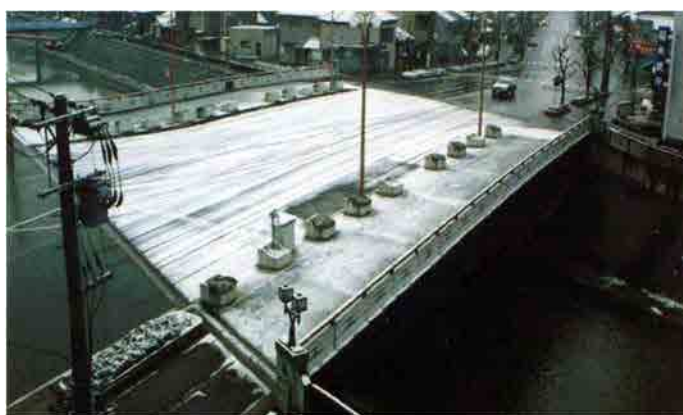
図 7-10-1. 鋼床版を用いた橋梁舗装の凍結状況
