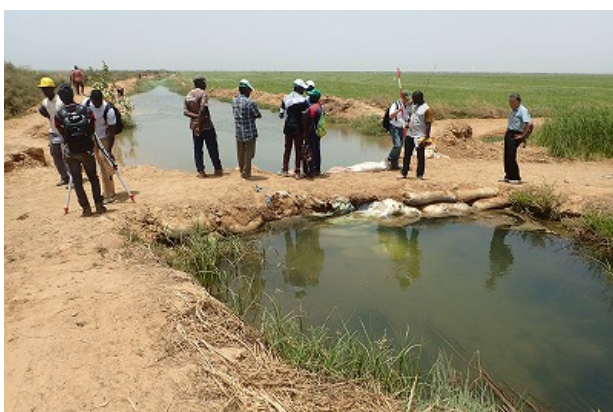
Passage existant pour le bétail sur le canal principal du périmètre de Rosso Le 11 juin 2019
