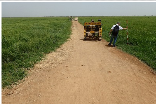
Piste Agricole construite par l'UNION du périmètre de Rosso Le 11 juin 2019
