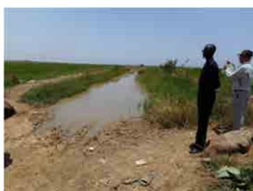
Voie pour la maintenance à Mbagan, Dagana
