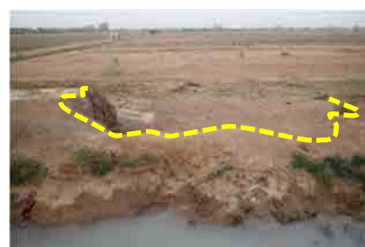
Voie pour la maintenance détériorée à Ndiwara, Podor
