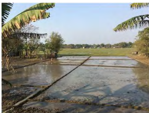
A1橋台(ドゥブリ)付近
