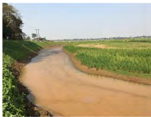
A2橋台(ブルバリ)付近
