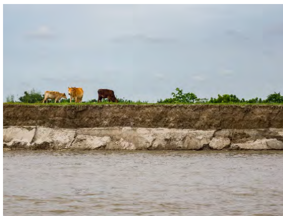
高さ6m程度の中州の細砂の崖、 上部の褐色部分は有機質
