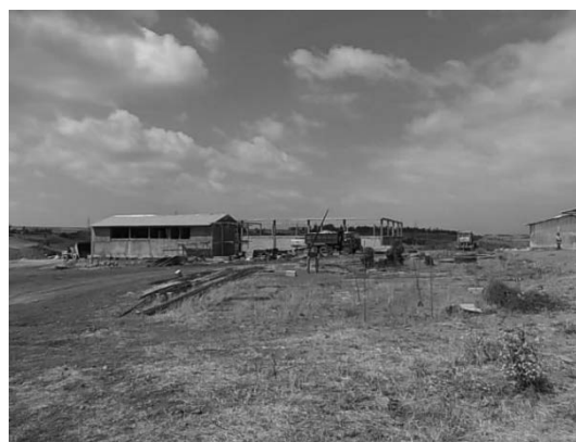
Bole中継基地（建設中）
