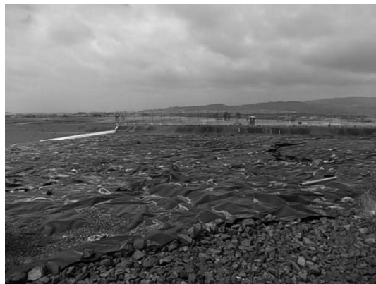
Sandafa衛生理立処分場
