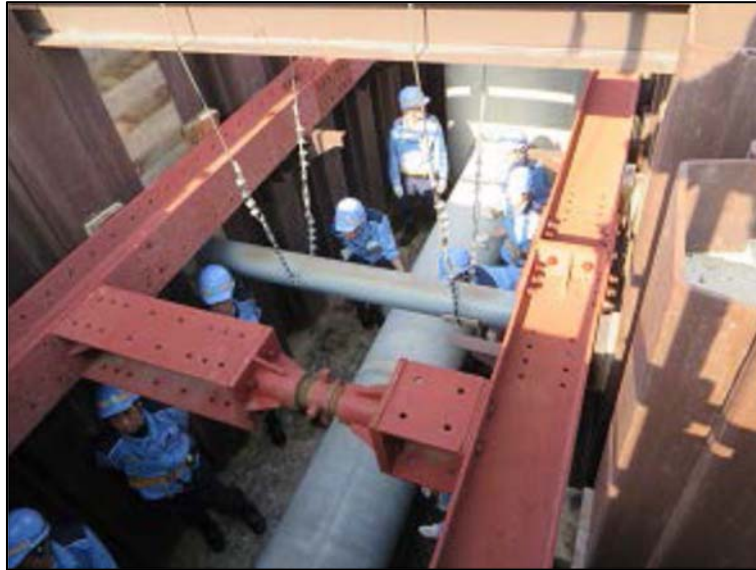
Hình 11.2.1 Ví dụ về Mô hình biện pháp thi công đào mở
