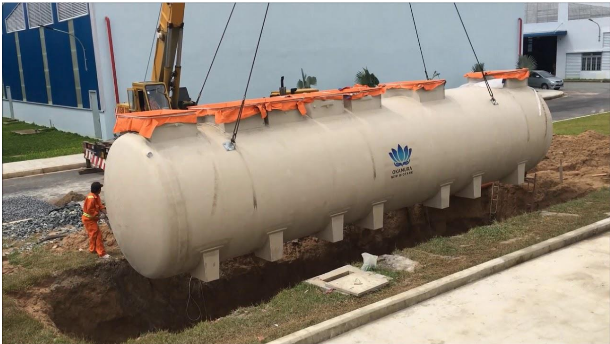
Hình 2 Ví dụ về cấu trúc bể Johkasou kích thước trung bình (chất liệu nhựa composite sợi thủy tinh)
