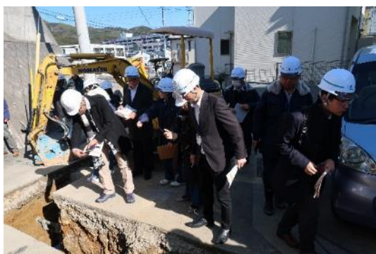
Công trường thi công tuyến cống chính
