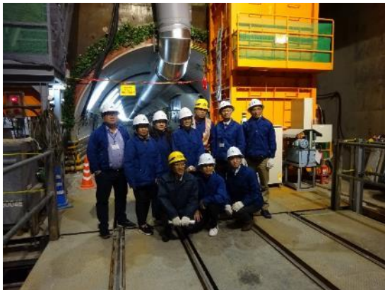
Giếng kích của đường ống trữ nước mưa
