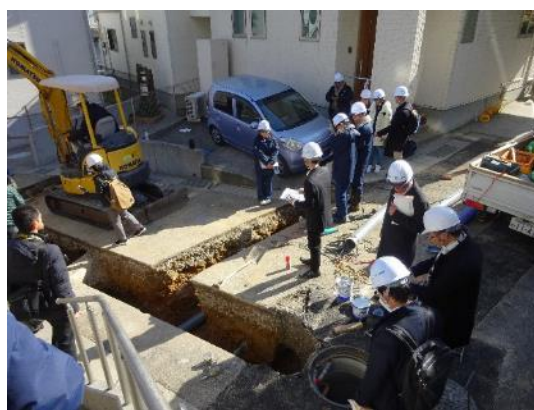
Công trường thi công tuyến cống chính
