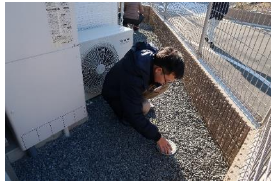
Công trình đầu nối
