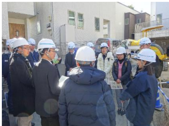
Công trường thi công đầu nối hộ dân
