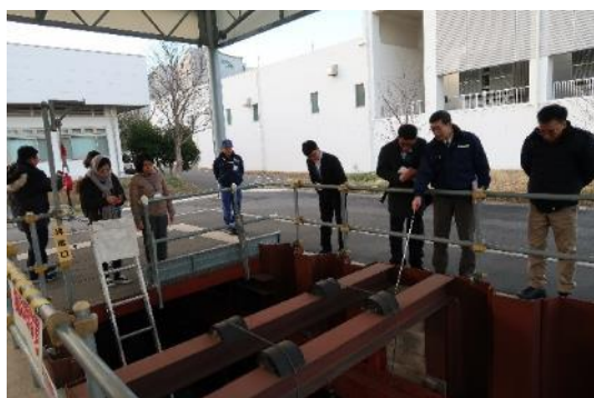
Thi công bằng phương pháp đào mở
