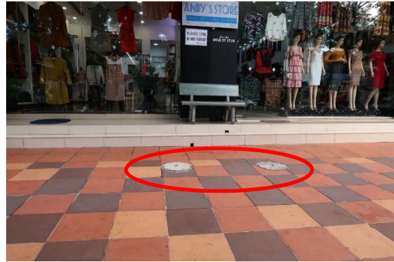
Hộp đấu nối nhận nước thải từ cửa hàng
