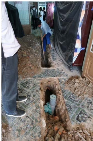
Công tác đấu nối nhà dân (bên trong nhà)
