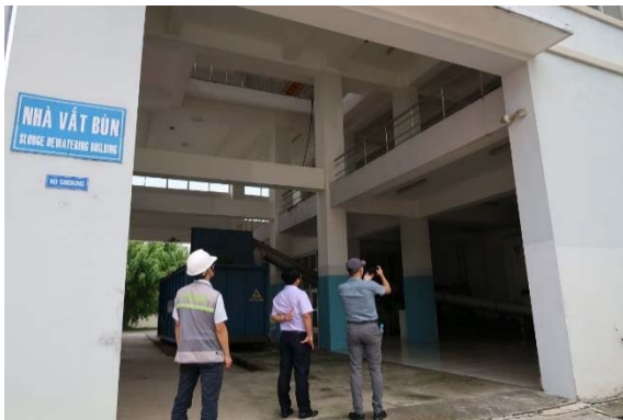
Nhà xử lý bùn
