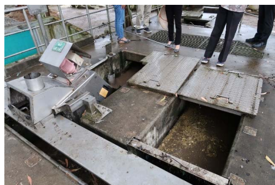
Bể lắng cặn
