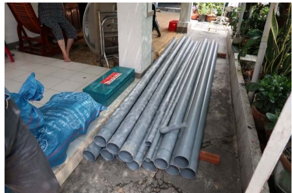
Ống công để đấu nối nhà dân
