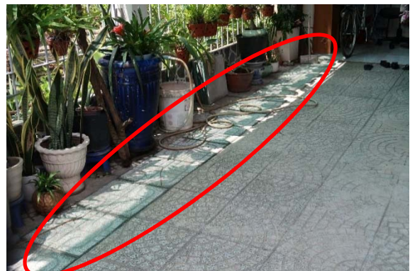
Thay gạch lát sau khi thi công xong.
