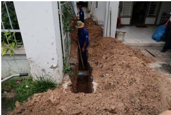
Công tác đào nối nhà dân
