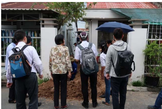
Hình 13 Công tác đấu nối nhà dân tại tỉnh Bình Dương
