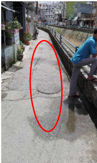
Đường ống được lắp đặt dọc suối
