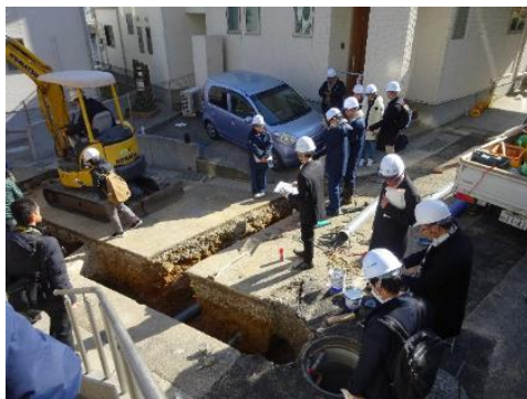
Công trường thi công cống chính
