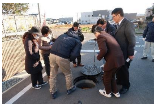
マンホール内の見学
