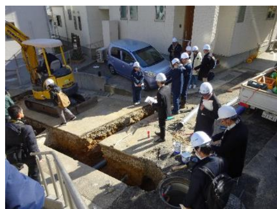
下水道本管施工現場の見学
