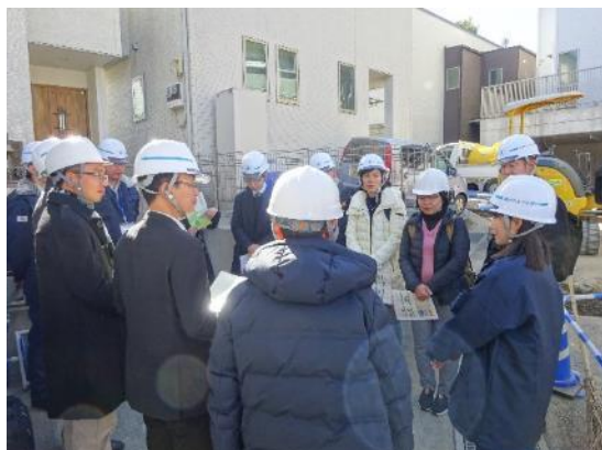
施工現場の概要説明
