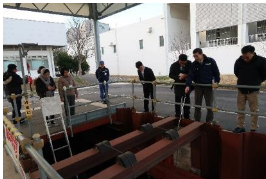
開削工事現場モデル見学
