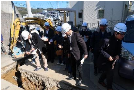
下水道本管施工現場の見学
