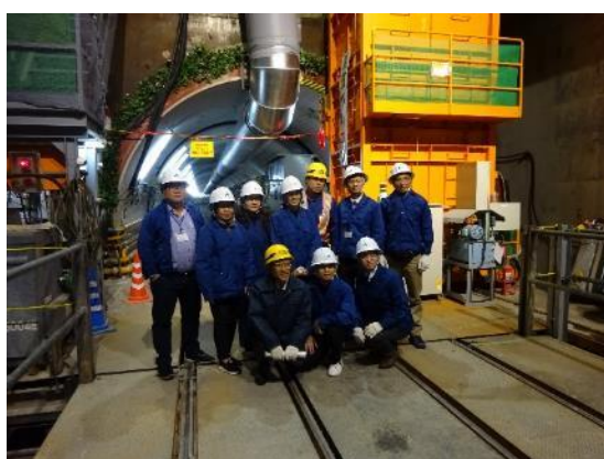
雨水貯留管発進立坑
