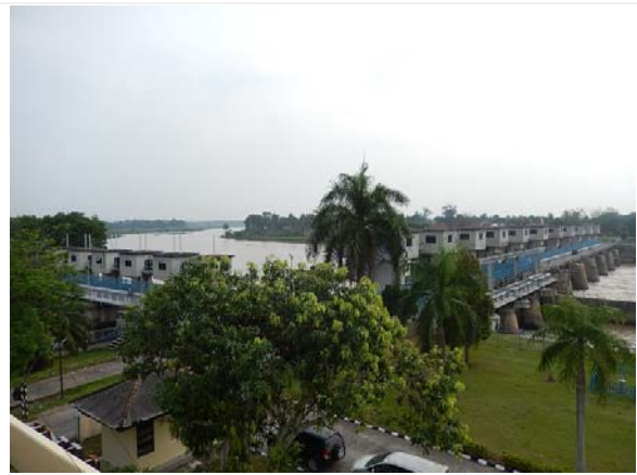
Perjaya Headwork (Komerling Irrigation System)
