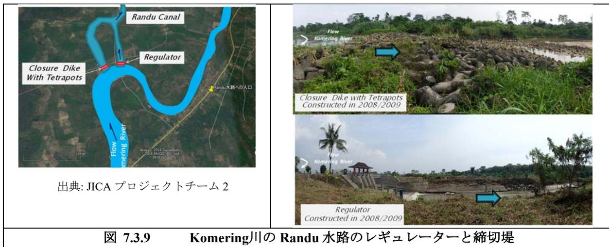
図 7.3.9 Komering川の Randu 水路のレギュレーターと締切堤
