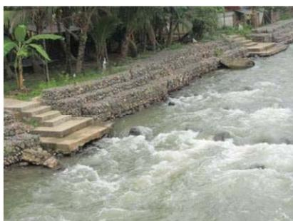
侵食による護岸工の沈下と変形
