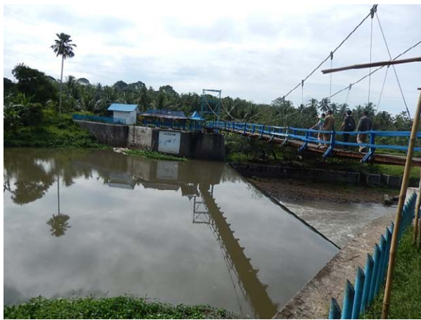
Water Vang 型頭首工 (Tughumulyo 灌漑システム)
