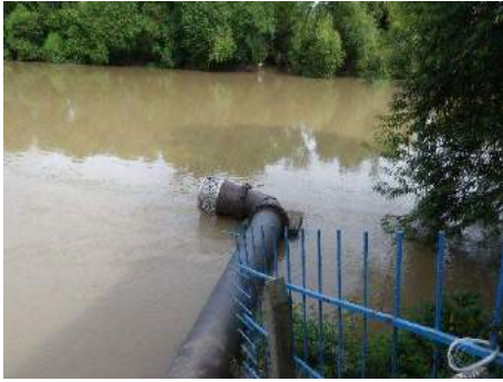
រូប-1 បំពង់បើកទឹកខាងលើ និងគម្រងសំណាញ់ បញ្ជូនទឹក(បំពង់បើកទឹកខាងក្រោម លិចក្នុងទឹក)
