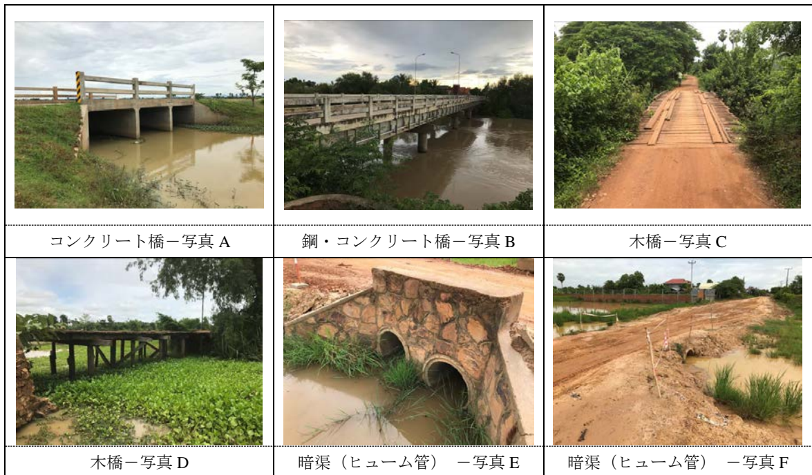
図 3-2-30 橋梁、暗渠写真
