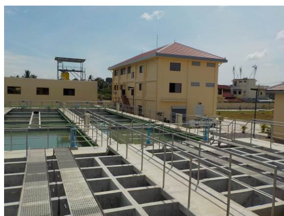
写真 2-2：バタンバン浄水場 (2017 年 6 月)
