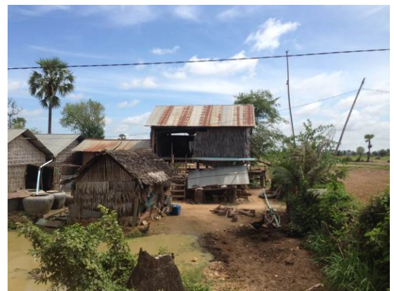
写真 4-4：民家の家屋。左側の建物において、雨水を集水できるよう、屋根から水がめへパイプが設置されている。(2017年7月)
