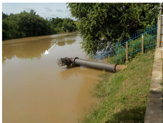
写真 1-1 : 既存取水施設 (2017 年 6 月)
