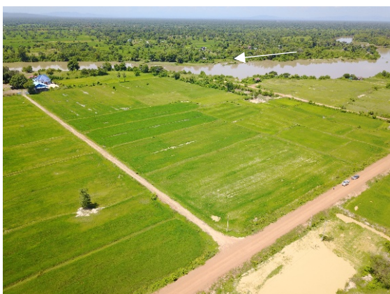
写真 2-3：新規浄水場用地 プルサット川左岸 (2017 年 8 月)
