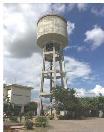
写真 1-6 : 既存浄水場内高架水槽 (2017 年 6 月)
