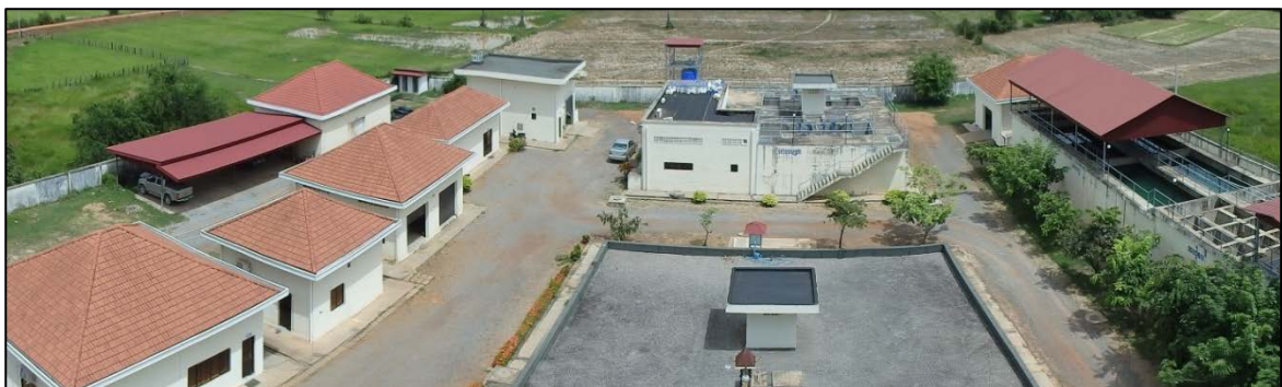
(左) 事務所、水質分析棟等 (中央) ろ過池、浄水池 (右) 沈澱池等
