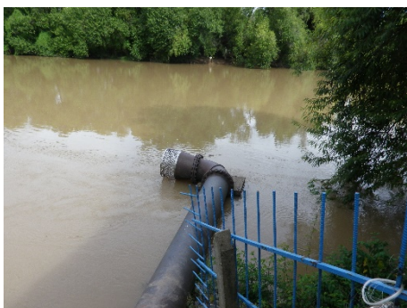
① 既存上部導水管（下部管は水中内）
