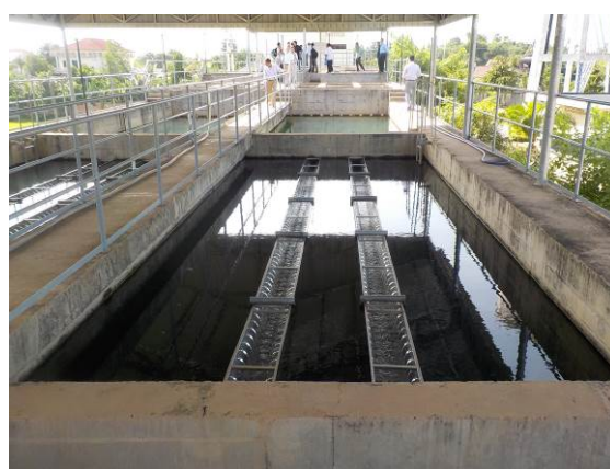
写真 1-4 : 既存浄水施設 (2017 年 6 月)
