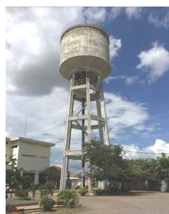
写真 1-6 : 既存浄水場内高架水槽 (2017 年 6 月)
