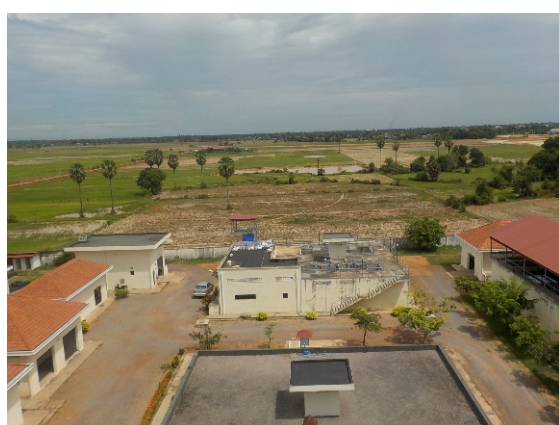
写真 1-5 : 既存浄水場全体図 (2017 年 6 月)
