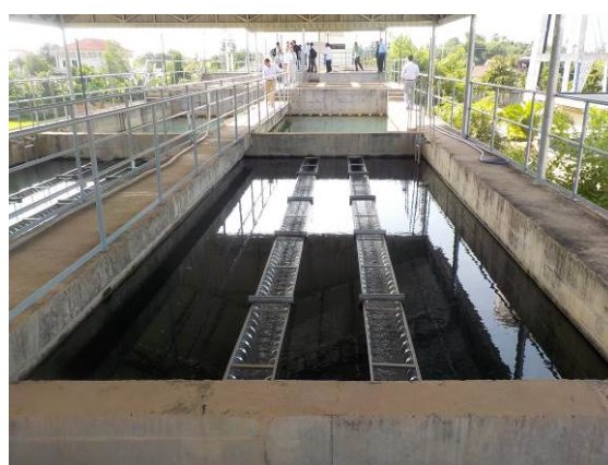
写真 1-4 : 既存浄水施設 (2017 年 6 月)
