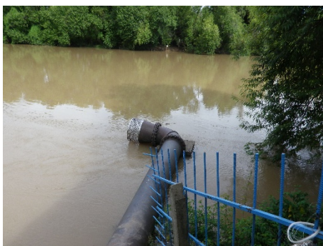
① 既存上部導水管（下部管は水中内）
