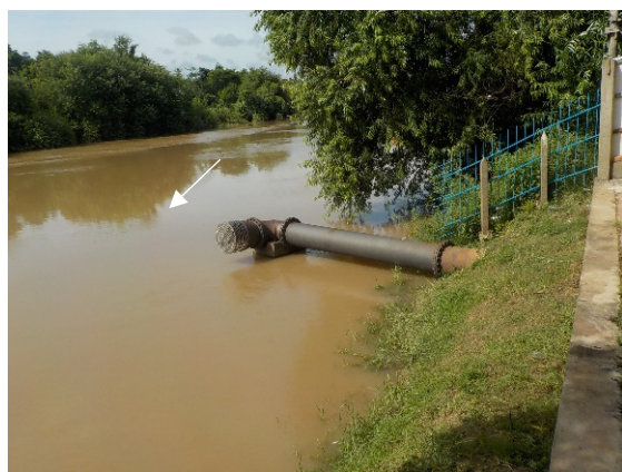
写真 1-1 : 既存取水施設 (2017 年 6 月)
