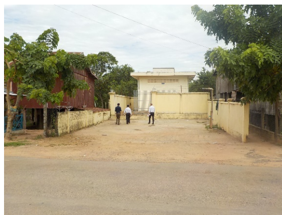
写真 1-2 : 既存取水ポンプ場 (外観) (2017 年 6 月)
