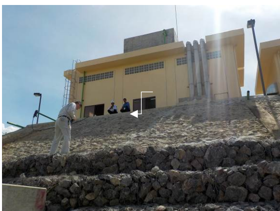
写真 3-1：バタンバン取水場 (2017 年 6 月)
