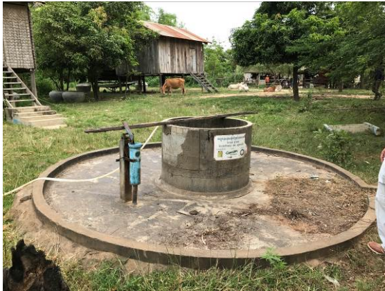
写真 4-1：地域単位で設置された浅井戸。写真撮影時は井戸枯渇により使用されていなかった。 (2017年7月)
