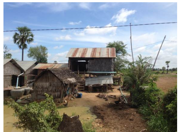
写真 4-4：民家の家屋。左側の建物において、雨水を集水できるよう、屋根から水がめへパイプが設置されている。(2017年7月)
