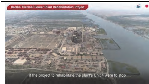
ハルサ発電所改修事業：overview
