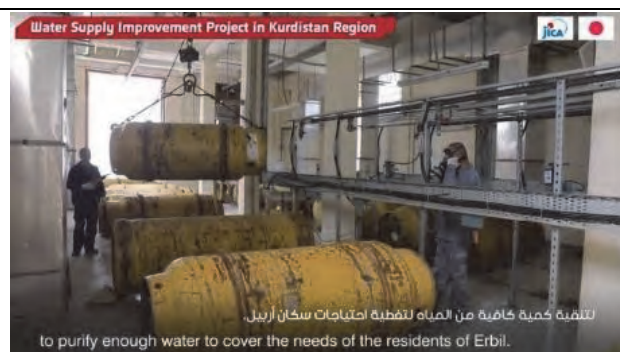
クルド地域上水道整備事業：overview
