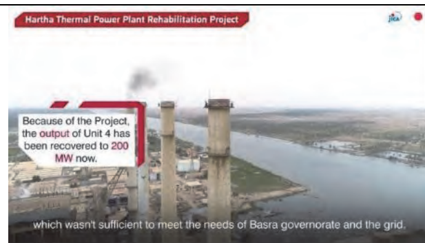
ハルサ発電所改修事業：overview
