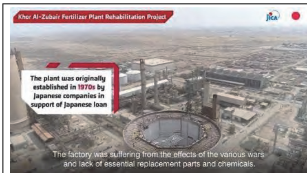
コール・アルズ・ベール肥料工場改修事業：overview
