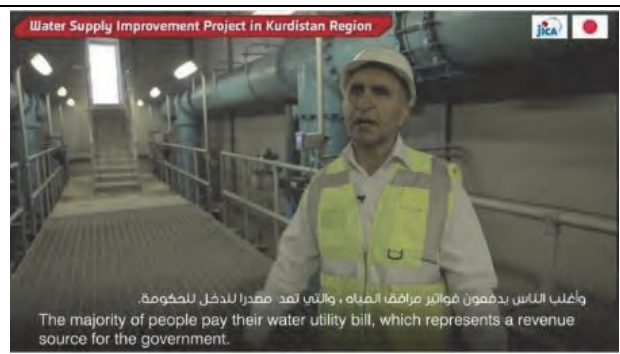
クルド地域上水道整備事業：overview
