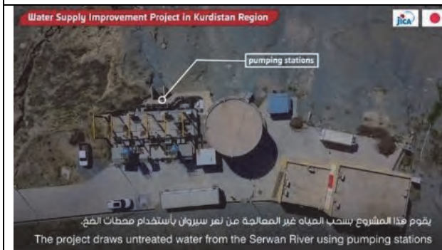
クルド地域上水道整備事業：overview
