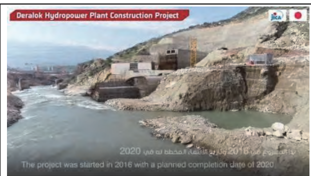
クルド地域電力セクター復興事業：テラロック水力発電所建設事業：overview
