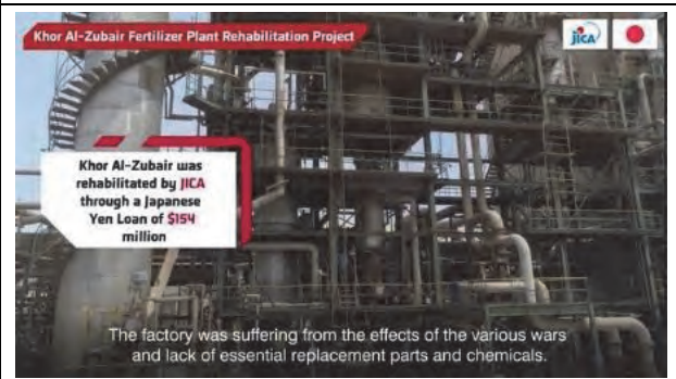
コール・アルズ・ベール肥料工場改修事業：overview
