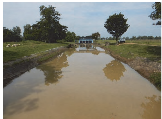
灌漑水路及び管理道路 (KM16+100)
