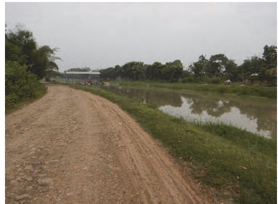
灌漑水路及び管理道路 (KM12+140)
