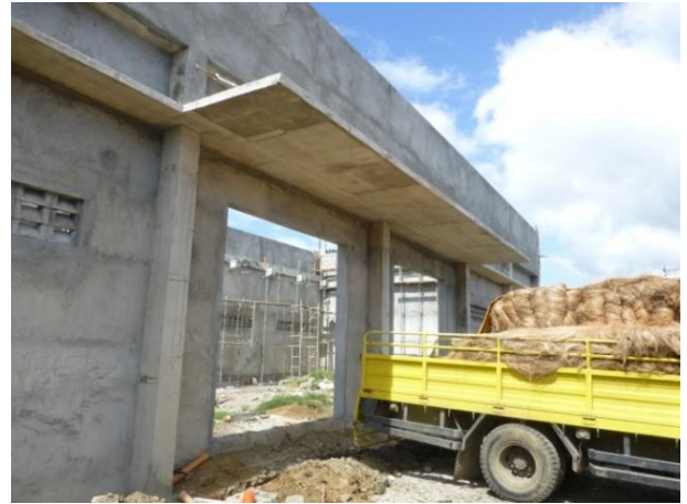
PLDC 倉庫 (建設中) (カタンドアネス州バト地区シピ PLDC マニラ麻集荷場)
