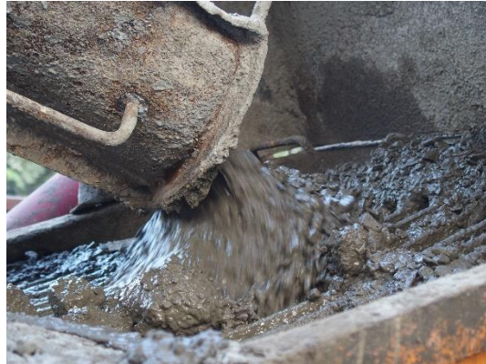
ミキサー車から生コンが供給される様子
