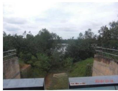
排水機場、クアantan川への放流路
