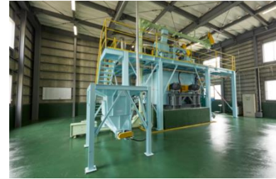
写真：水銀安定化設備
