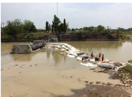
写真-10：仮締切復旧（2017/10/28）
