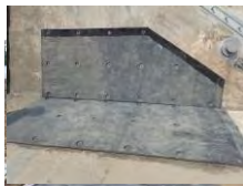
(11) Pemasangan Pelindung Karet
