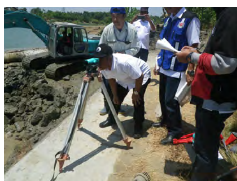
写真-25：完工検査 (2018/9/25)
