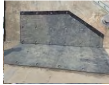
(11) Pemasangan Pelindung Karet
