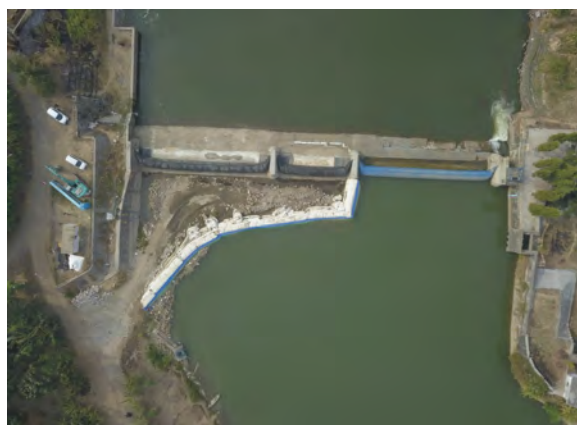
写真-4: 仮締め切り再設置 (2018/7/6)
