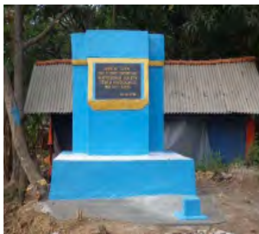
写真-43：慰霊碑修復
