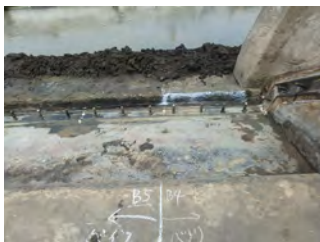
写真-15：アンカー交換前
