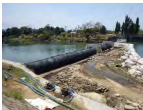
写真-23：本体起立試験 (2018/9/15)
