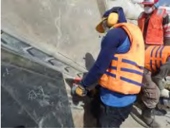
(9) Penggantian Baut (pemotongan)
