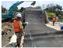
(12) Pemasangan #2 (sebelah kiri)
