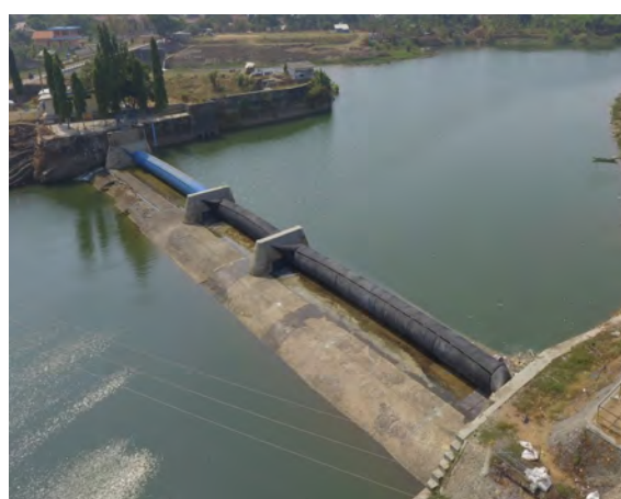
写真-6: 完工状況 (2018/10/3)
