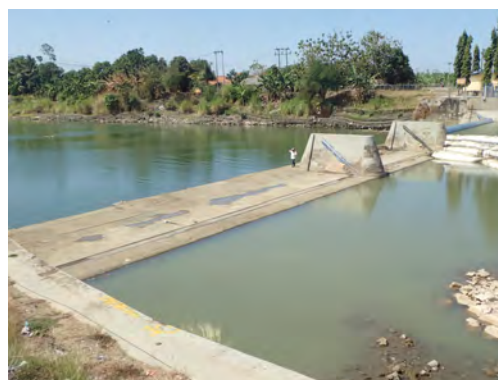
写真-12：本体撤去後
