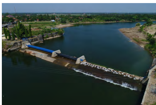
写真-1：工事開始前（2017/5/24）
