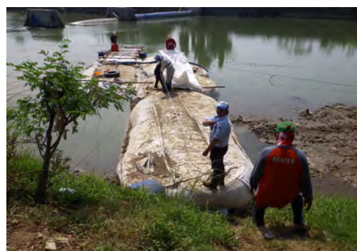
写真-8：仮締切設置開始（2017/7/6）
