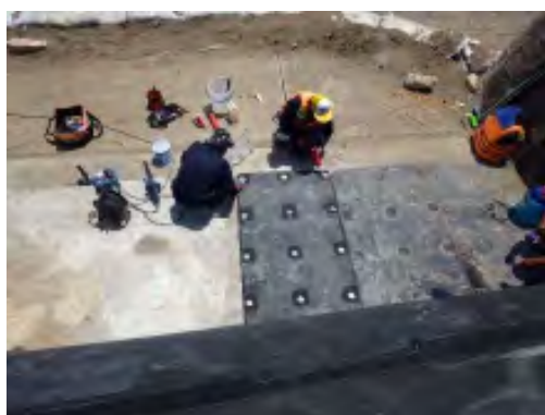
写真-22：保護マット設置 (2018/9/13)
