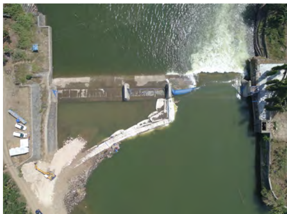
写真-2: 仮締切設置状況俯瞰 (2017/9/21)
