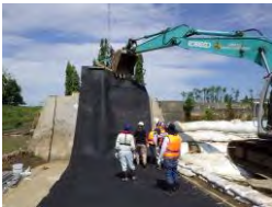
(5) Pemasangan no2 (Pertama)
