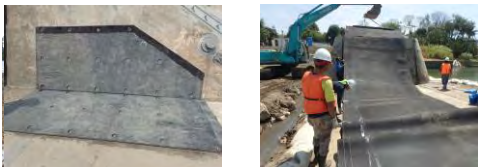
(11) Pemasangan Pelindung Karet (12) Pemasangan #2 (sebelah kiri)
