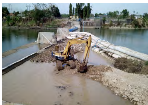
写真-9：アクセスロード整備（2017/10/6）
