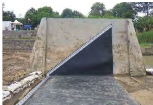
写真-19：#2 本体設置完了（2017/10/17）
