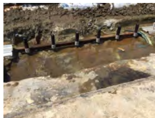
写真-16：アンカー部削り
