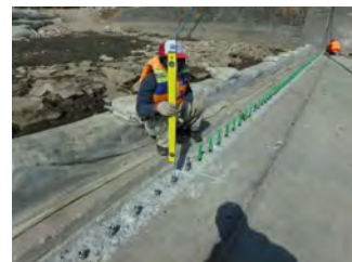
写真-17：アンカー交換後
