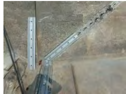
(10) Pemasangan klemping
