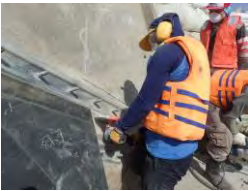
(9) Pengantian Baut (pemotongan)
