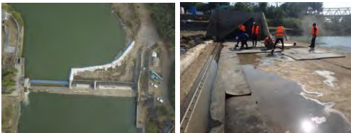
(7) Pembuatan Kisdam (2018) (8) Pembongkaran #2
