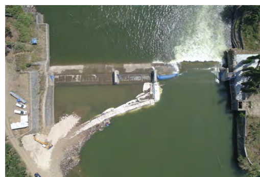
写真-2：仮締切設置状況俯瞰（2017/9/21）
