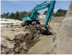
(15)Pembongkaran Jalan Akses
