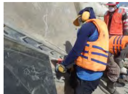
(9) Pengantian Baut (pemotongan)
