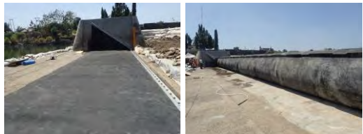
(13) Pemasangan No 1 (14) Uji Coba
