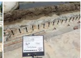
(4) Pengantian Mur Baut
