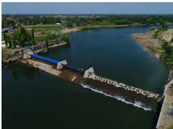
写真-1: 工事開始前 (2017/5/24)
