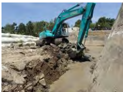
(15)Pembongkaran Jalan Akses
