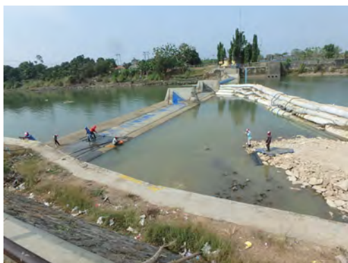
写真-11：本体撤去前
