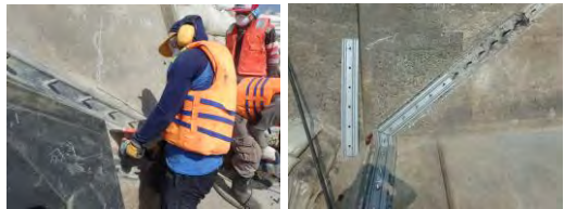
(9) Pengantian Baut (pemotongan) (10) Pemasangan klemping
