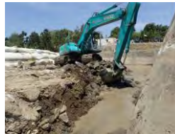
(15) Pembongkaran Jalan Akses
