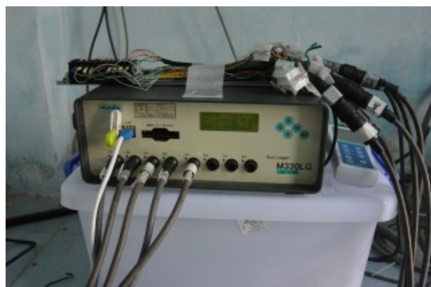
子局データロガーによるデータ転送テスト(2018.10.25)
