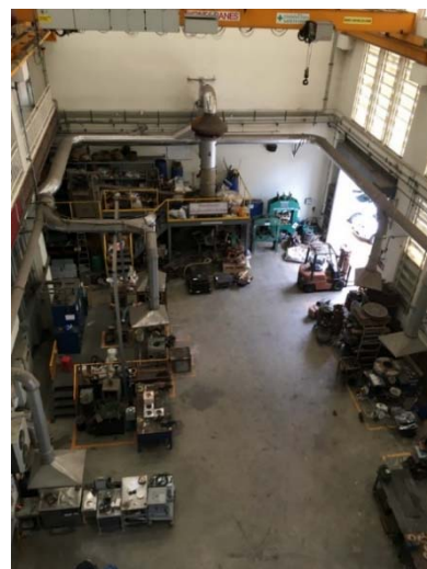
写真 2-24 小型高周波電気炉
