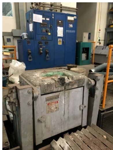
写真 2-22 溶解試験設備全景
