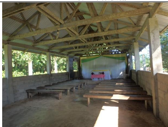
ブルタケア村の教会（電気供給先候補）
