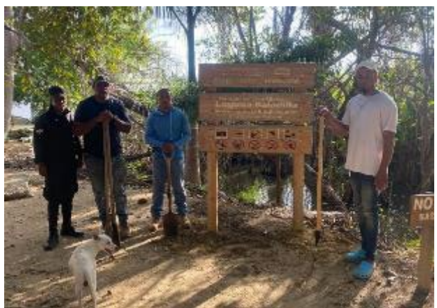
Instalación de señales que indiquen los límites de las zonas protegidas
