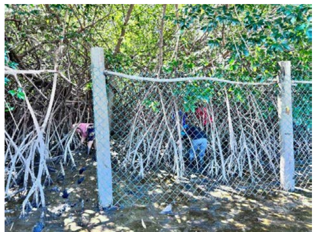
建設した貝養殖場。
