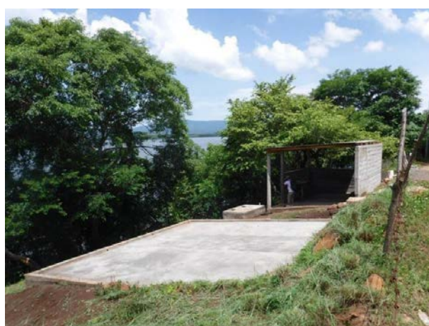
組合が購入した土地に建設された餌製造場。手前が、材料乾燥場、奥が材料を茹で、粉碎、ペレットを製造する小屋。
