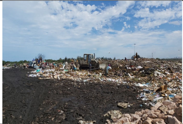
ウレネ処分場視察（11日） （DSMAS による埋立区画整備工事）
