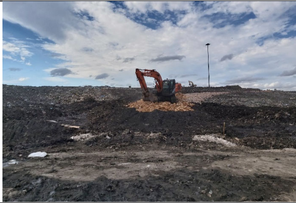
ウレネ処分場視察（11日） （日本国環境省支援による搬入道路改善工事）
