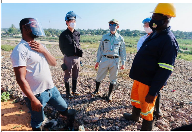
ウレネ処分場の現場視察 (27 日)
