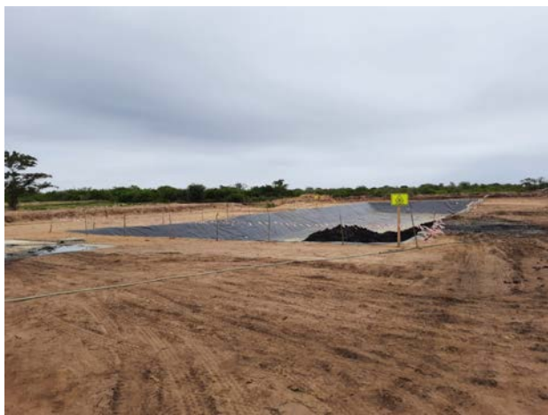
成果 4：カテンベ処分場予定地隣で運営開始された汚泥処分場（1 日）
