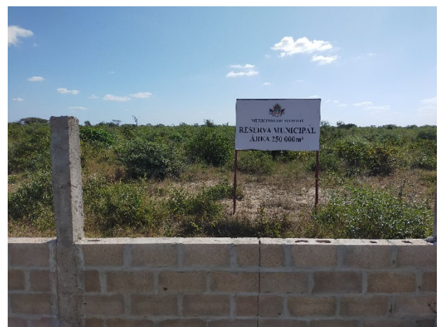
カテンベ処分場建設予定地の現場視察（29 日）
