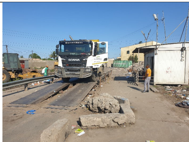
ウレネ処分場の現場視察 (14 日)
