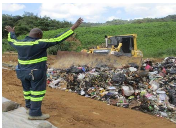
ドーザーによるごみの敷均し
