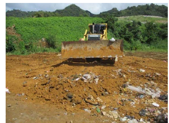
トレーニング最終覆土 (3層目)
