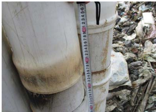
ガス抜管の設置
