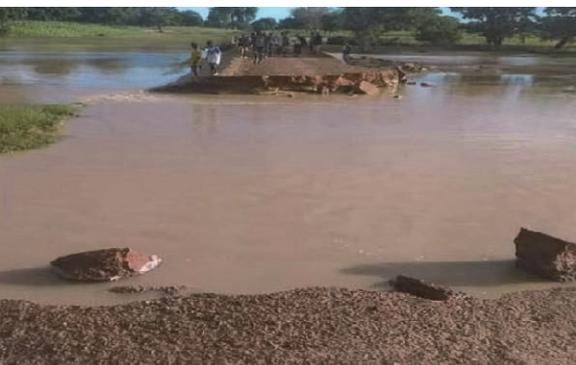
写7 洪水災害による地方道(簡易舗装)の損傷 道路が寸断している
