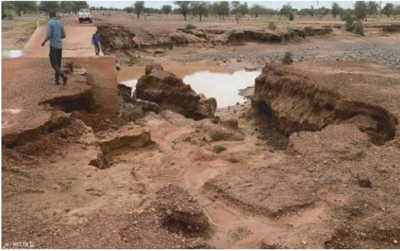
写 9 地方道橋梁取り付け部の損傷
