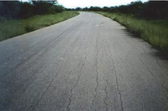
写3 郊外国道 縦断方向のひび割れ
