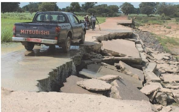
写8 地方道(舗装)の損傷。コンクリート舗装の「洗い越し」\*が損壊
