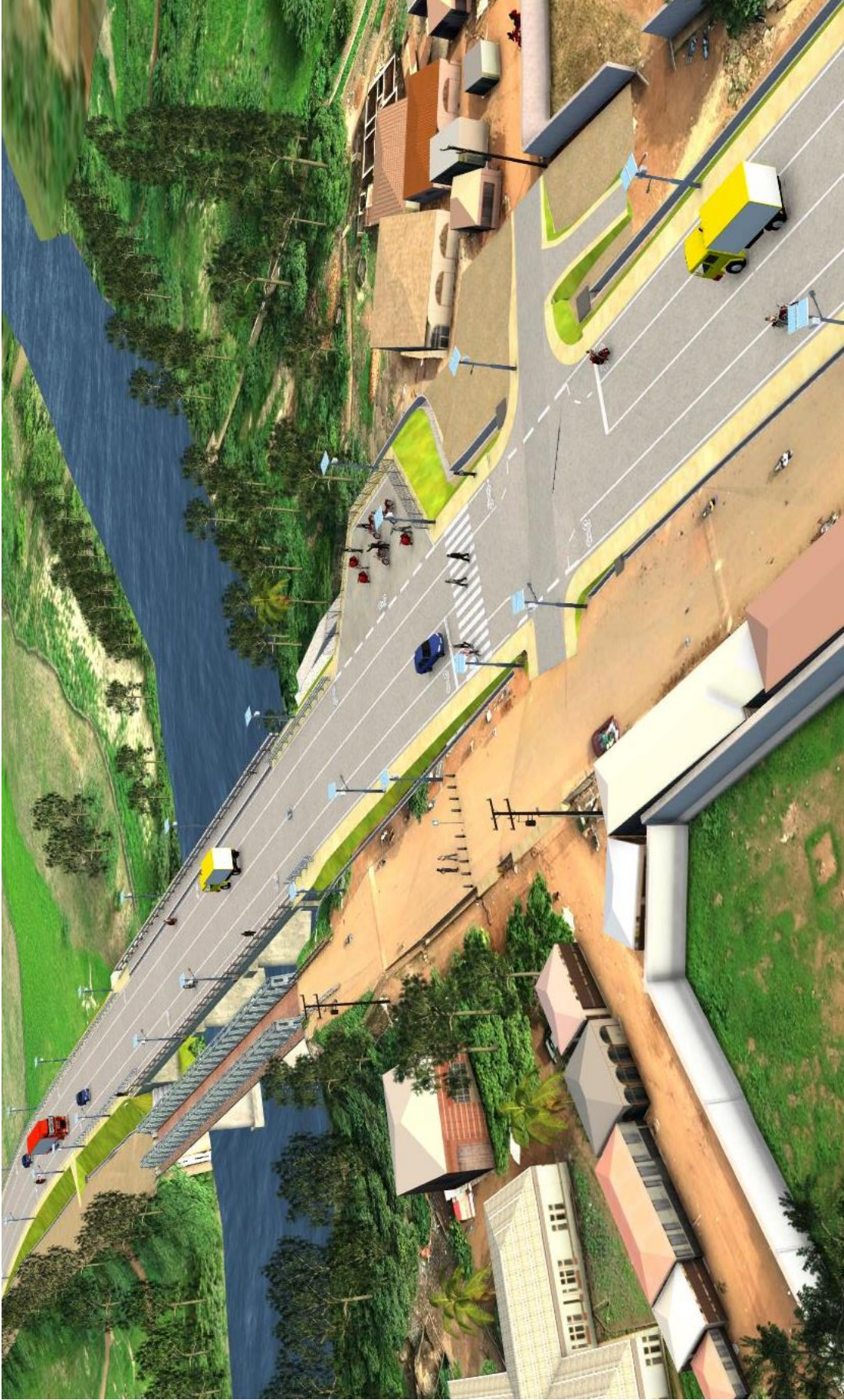
Vue du projet achevé (pont Faranah vu depuis le nord-ouest)
