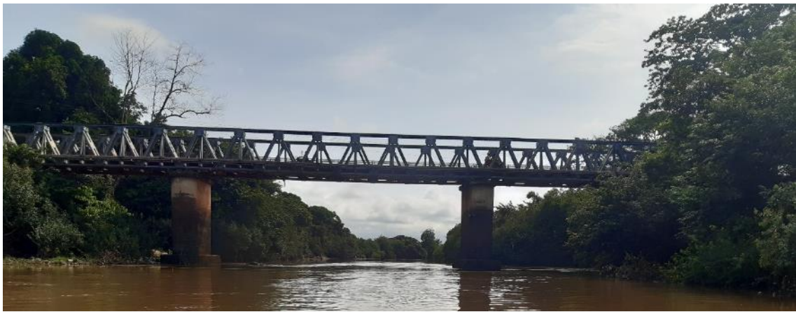
Vue d'ensemble du pont Faranah (depuis l'amont)
