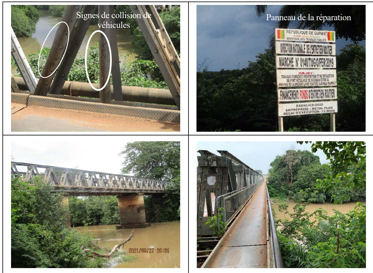
Figure 2-1-8 État actuel du pont Faranah
