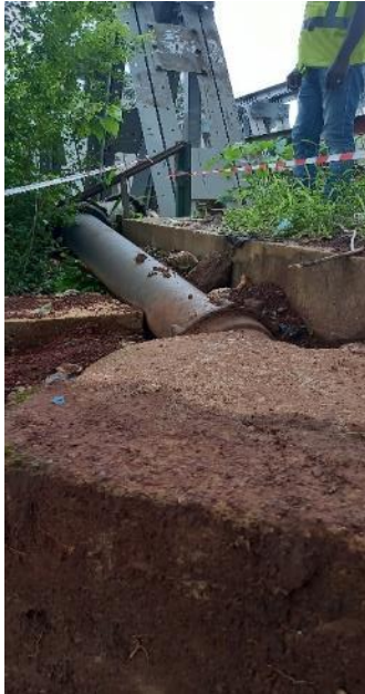
Tuyau d'eau 250 mm
