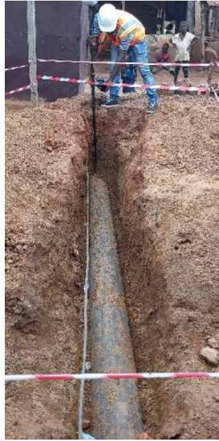
Tuyau fonte 250 mm et câble électrique
