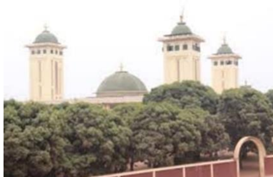
Source : CERE (2023). EIES. Projet de reconstruction du pont Faranah de la route nationale N°2 sur le fleuve Niger en République de Guinée.
