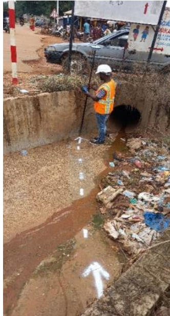
Tuyau PVC 90 mm et câble
