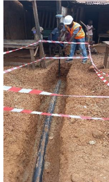
Tuyau PVC 90 mm et câble longeant la RN2
