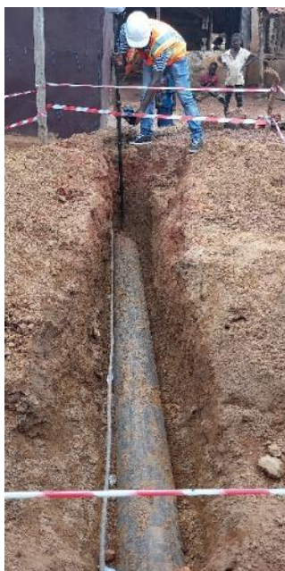
250mm の鑄鉄管と電カケーブル
