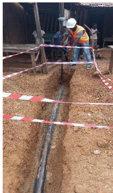
PVC90 と RN2 に沿ったケーブル
