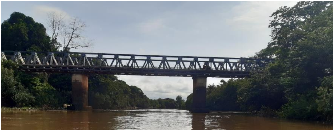
ファラナ橋全景（上流から臨む）
