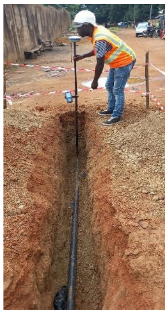
浄水場へ給電する PVC63mm パイプ
