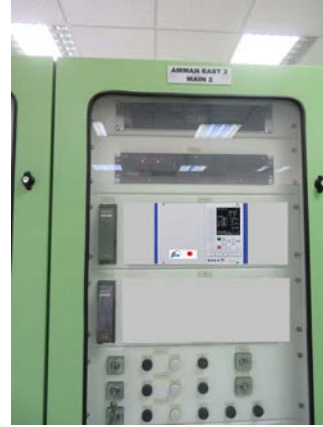
リレー取替後
