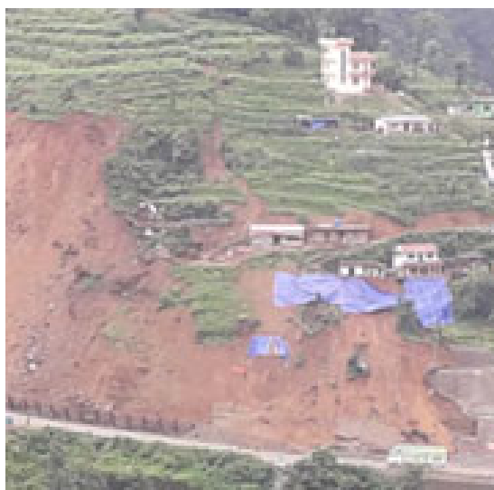
写真 2.7.1 斜面崩壊に対する防水シート掛け
