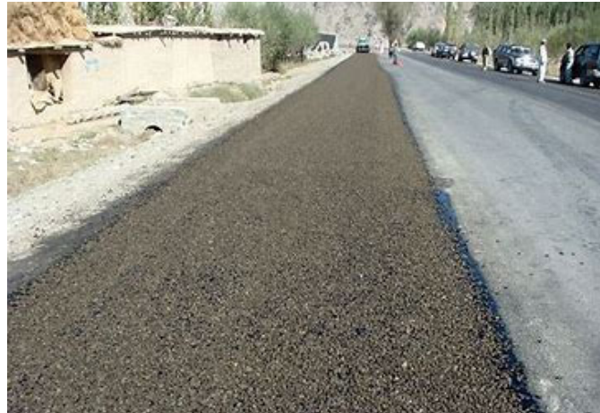
写真 2.7.2 DBST による舗装表層の路面被覆
