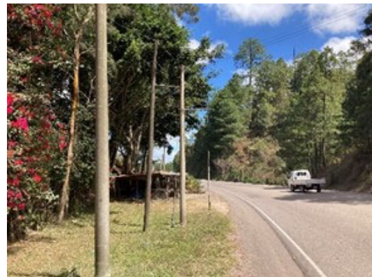
【電信柱(終点側)】
