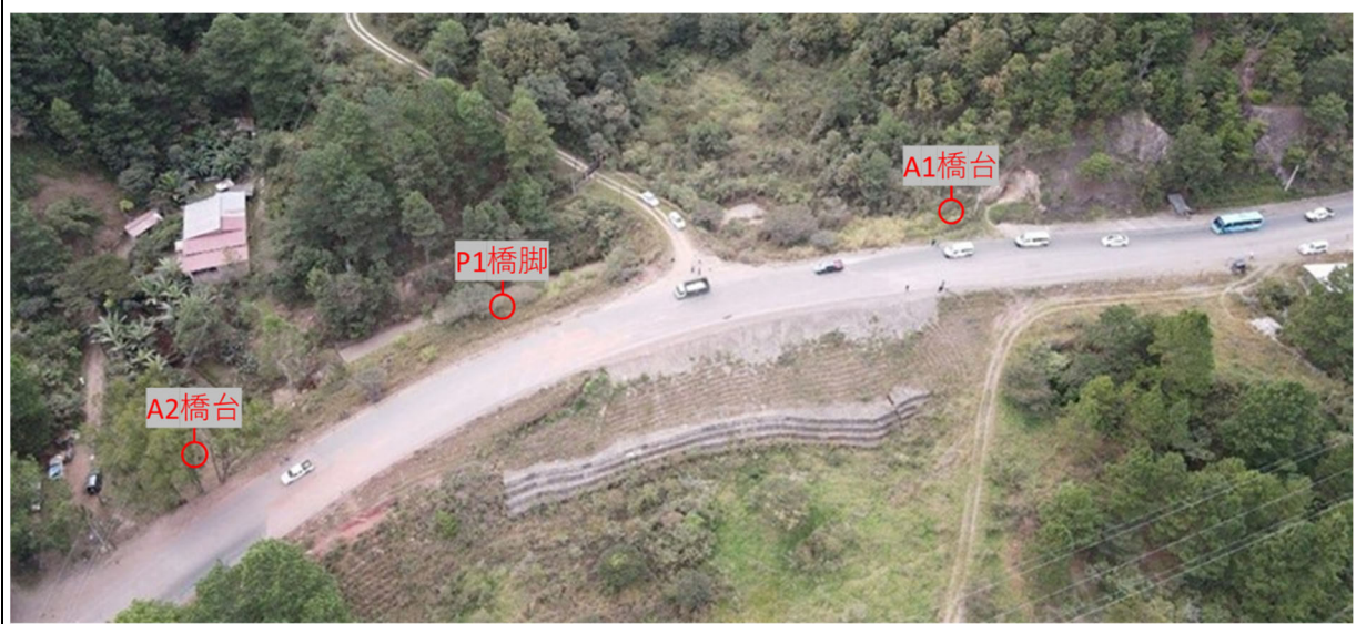
写真-1 CA6 の 16.3km 付近の現道の状況(1)
