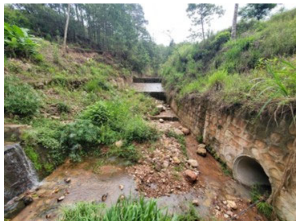
写真-7 山側水路(A2 橋台から A1 橋台を眺める)
