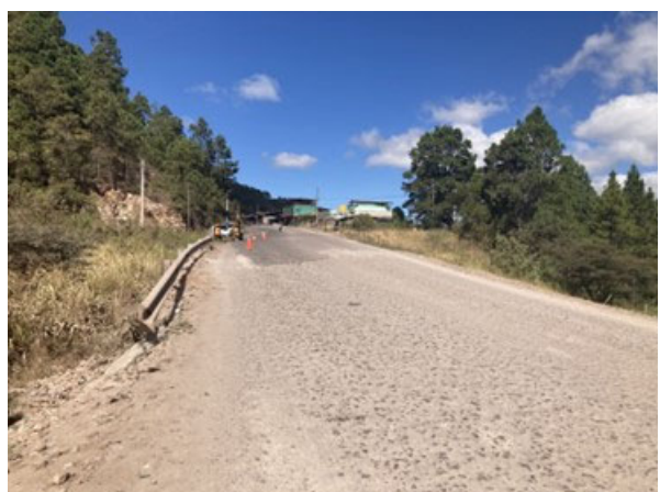
写真-5 現道の舗装状況(対象箇所東側)
