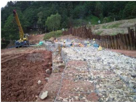
【工事実施状況】
