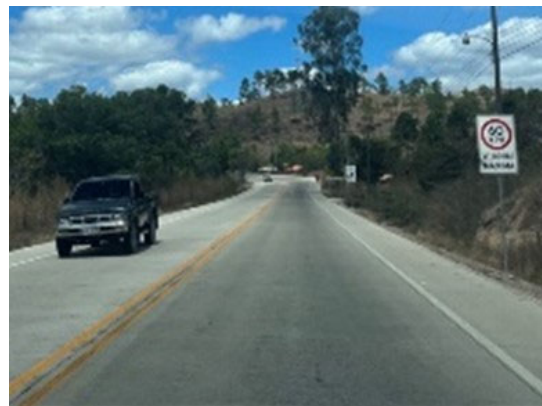
【コンクリート舗装区間】
