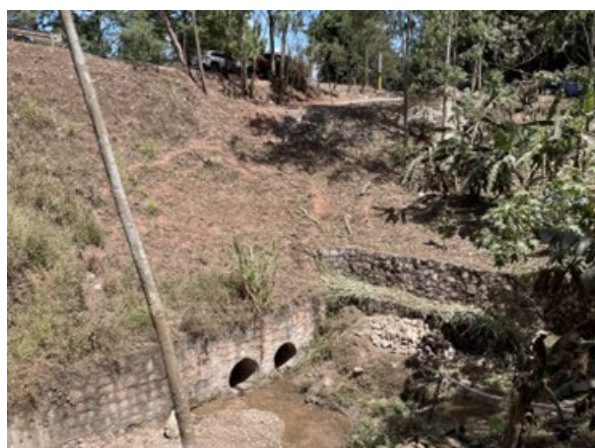
写真-8 山側水路(A2 橋台を眺める)
