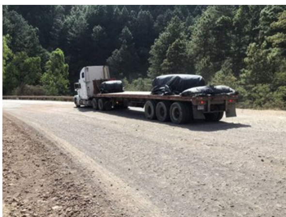
写真-4 現道の舗装状況(対象箇所西側)
