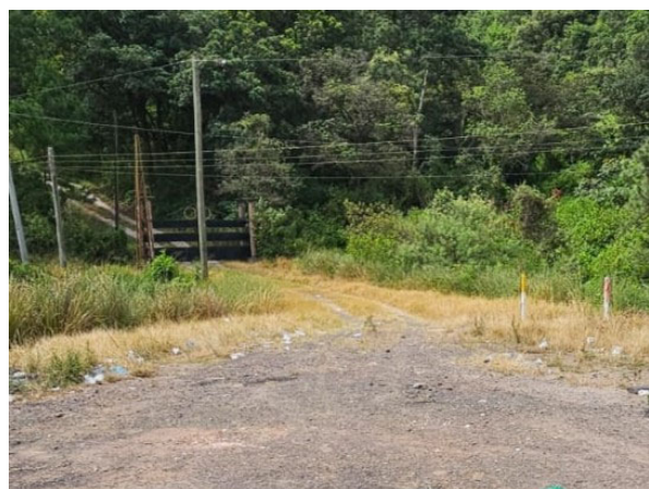
写真-10 アクセス道路(P1 橋脚付近)
