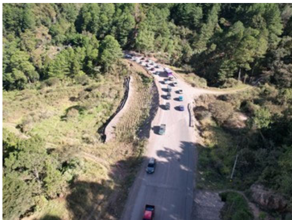
写真-2 CA6 の 16.3km 付近の現道の状況(2)
