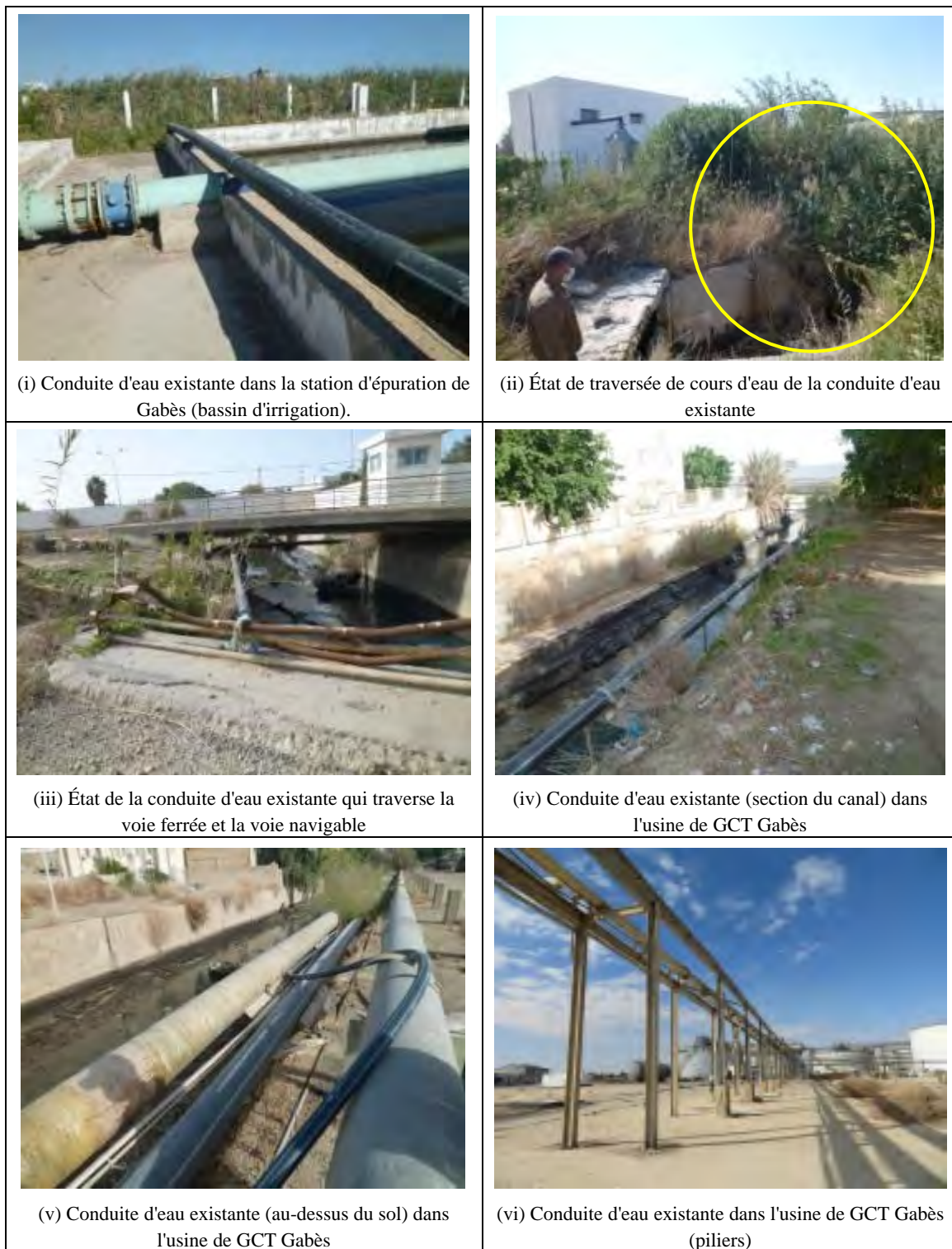
Figure 2-26 État de pose de la conduite d'eau existante
