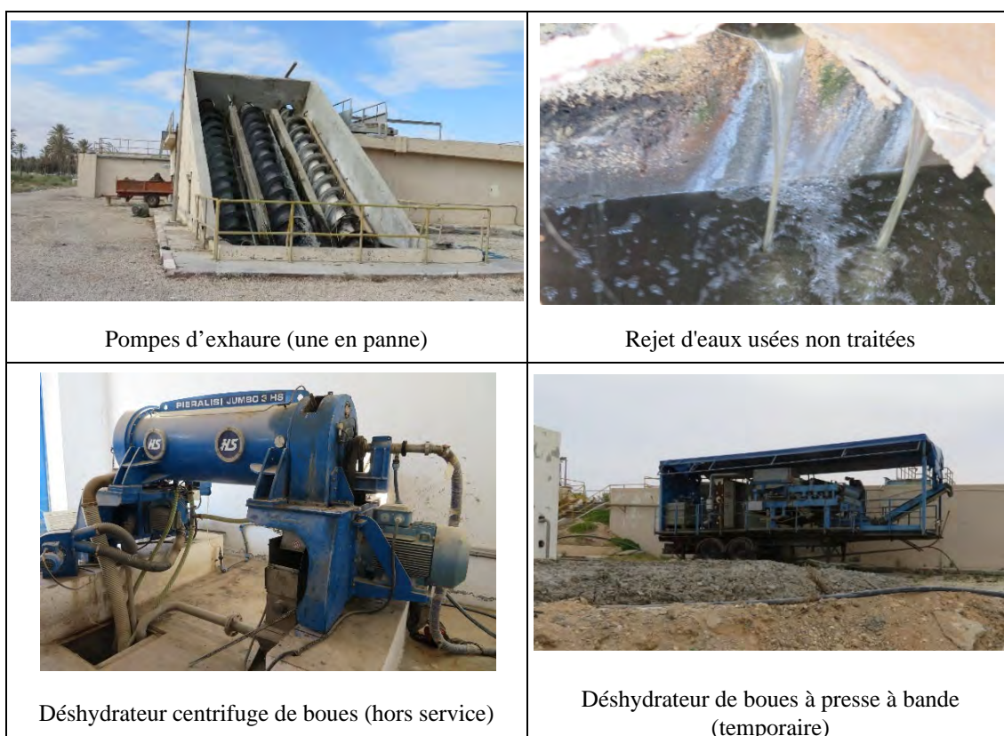
Figure 2-6 Problèmes de la station d'épuration de Gabès (traitement des eaux affluentes et des boues)
