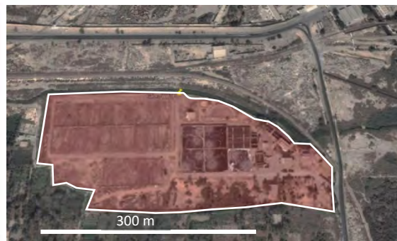
Station d'épuration des eaux usées de Gabès
