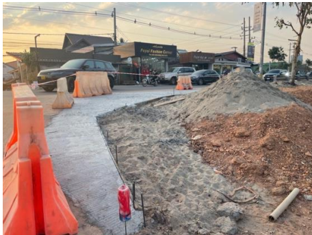
図 2.2-18 交差点改良の工事状況
