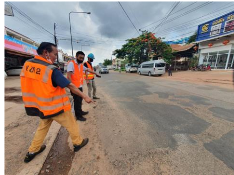
パイロット事業②路面補修現地調査 2022年6月
