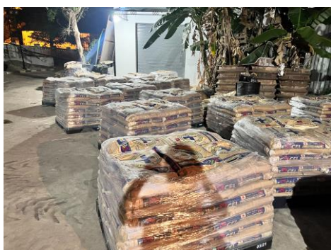
パイロット事業②道路補修材納入 2021年12月
