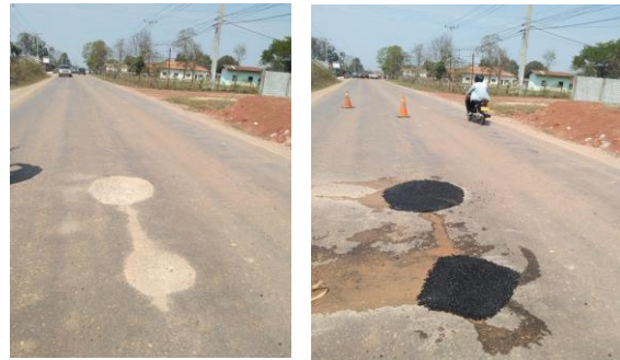
図 2.2-20 常温合剤の工事状況
