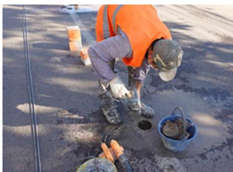
図 2.2-19 道路鋏の工事状況
