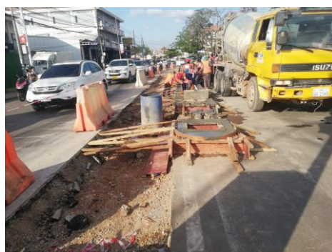
パイロット事業交差点改良施工中 2022年1月
