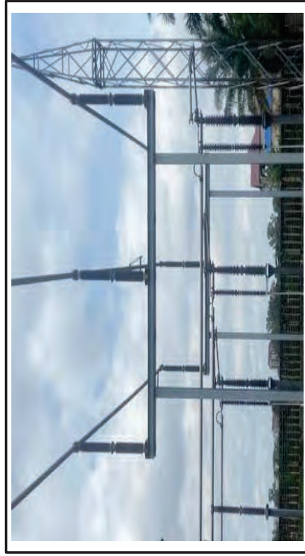
Photo n°07 : Sectionneur des points neutres de la sous station de la Funa
