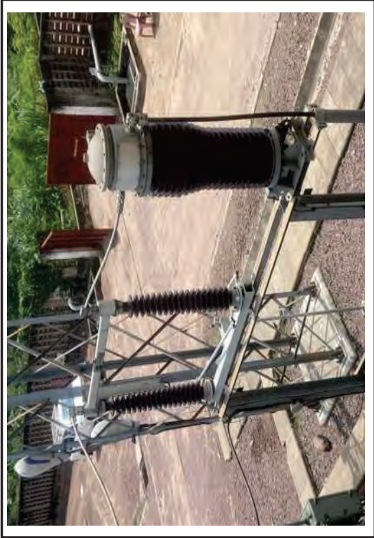
Photo n°07 : Sectionneur des points neutres de la sous station de la Funa
