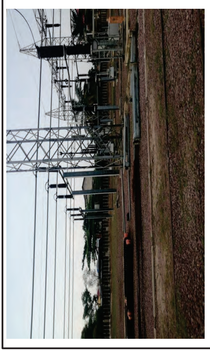
Photo n° 01 : Une vue de la Sous-station de LIMINGA avec jeux de barres
