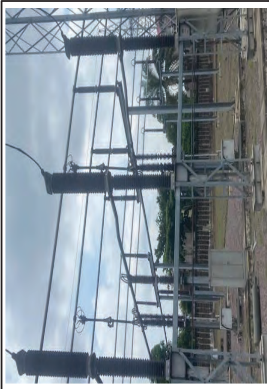
Photo n° 03 : Parafoudre de la sous station de la Funa
