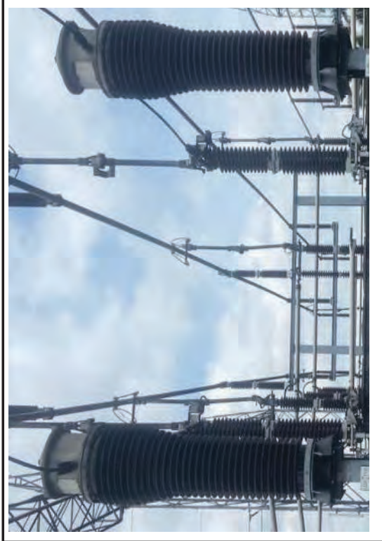
Photo n° 05 : Sectionneur Pantographe de la sous station de la Funa
