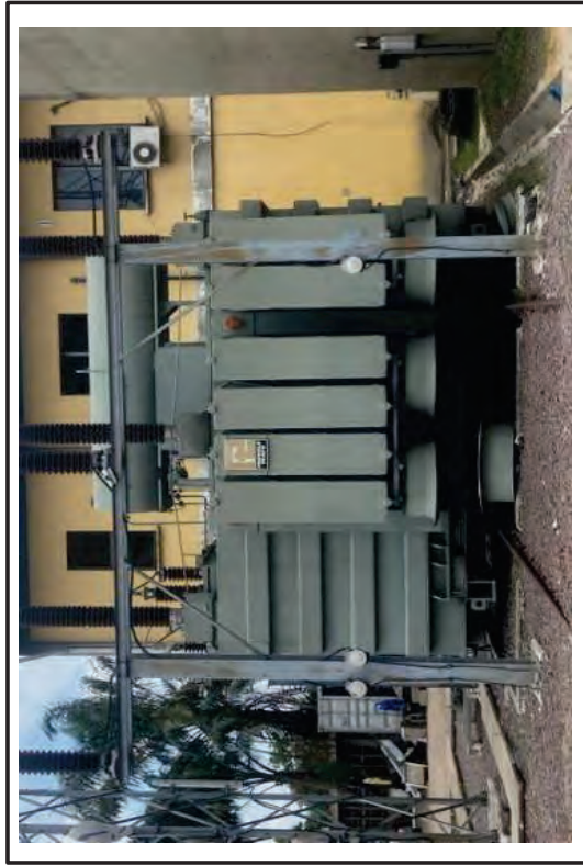
Photo.n° 01 : L'un de transformateurs de la sous station de la Funu
