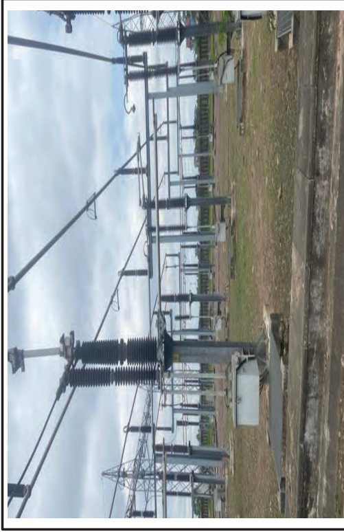
Photo n° 05 : Sectionneur Pantographe de la sous station de la Funa
