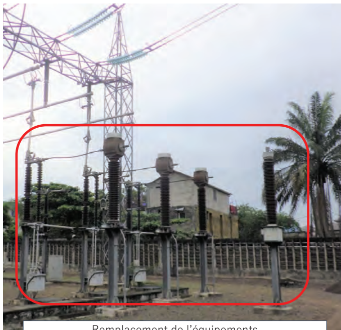
Remplacement de l'équipements et l'installation de conducteurs entre les équipements
