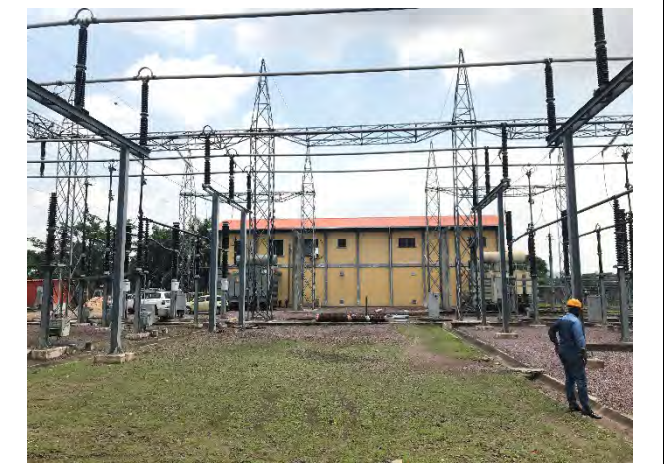
フナ変電所 220kV/20kV 変圧器及び開閉設備の設置予定地 既設変圧器 2 台の間のスペースに 220kV/20kV 変圧器及び 220kV 開閉設備を設置する計画である。
