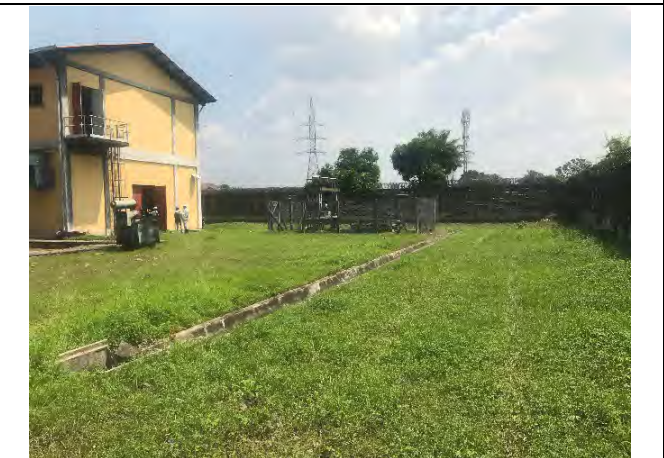
フナ変電所 建屋建設予定地(20kV 開閉設備用)
