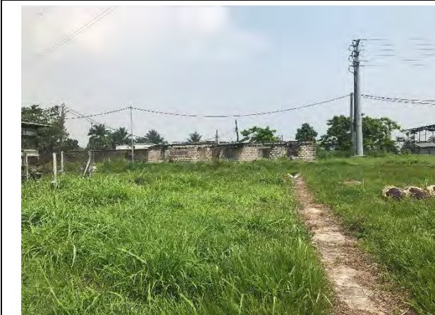
リミंगा変電所 建屋建設予定地(20kV 開閉設備用)
