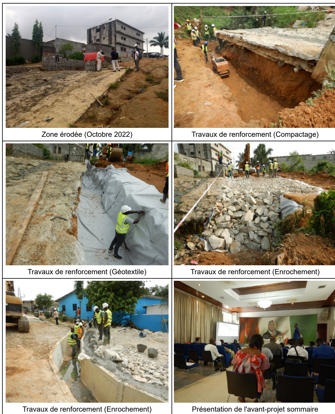
Figure 2.2.3 Travaux de renforcement et études techniques
