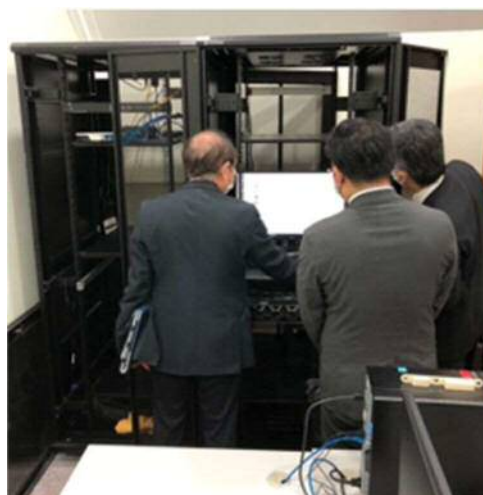
写真4 データセンター内のサーバーやス トレージ等の機材
