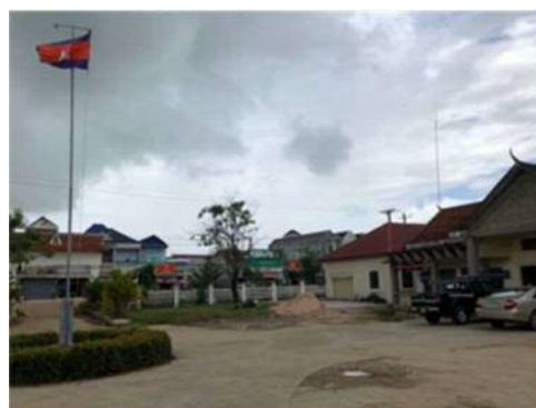
写真5 プノンペン郊外の電子基準点整備 候補地（地方事務所在地内）
