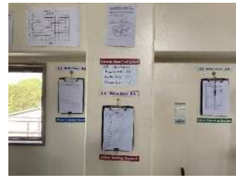
薬注点検・管理記録表及び記録 啓発標識の設置
