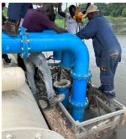
取水管吸込口の清掃の様子
