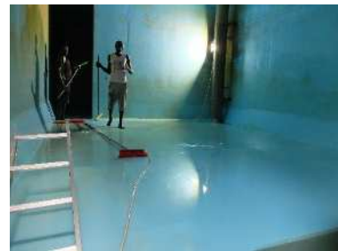
浄水タンク内部清掃中
