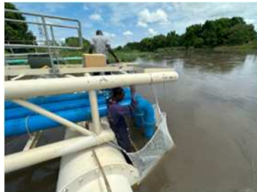
浮遊物流入防止用ネットの設置
