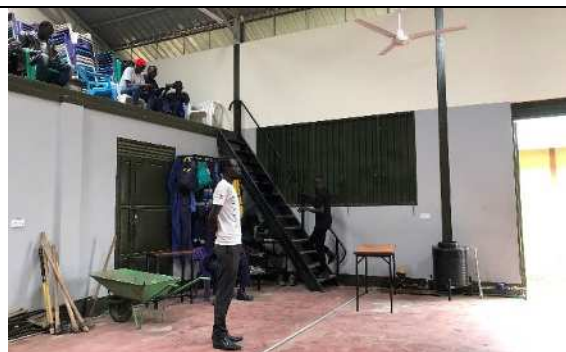
実習ホールの中のブースターポンプ設備
