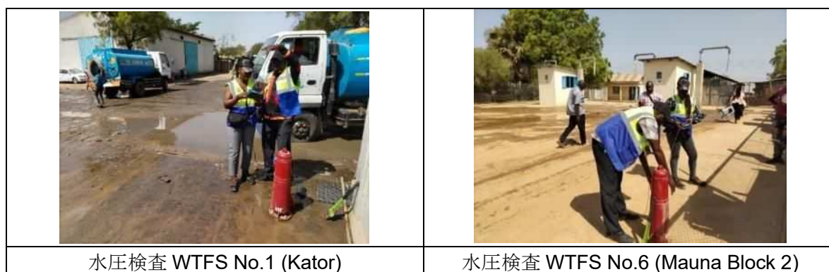
写真 8 水圧測定技術研修の様子
