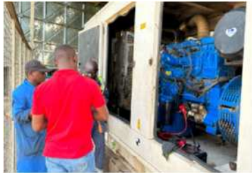
既存浄水場発電機メンテナンス
