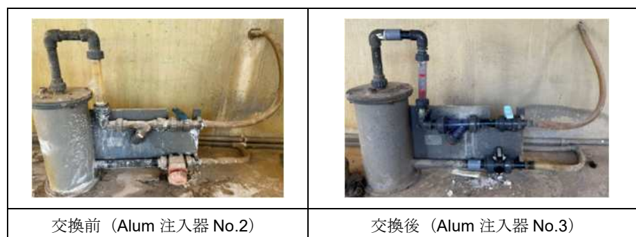
写真 13 薬品注入器の交換
