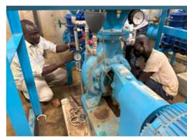
取水ポンプ清掃
