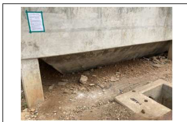
写真 11 沈殿池排泥 SOP の現場表示
