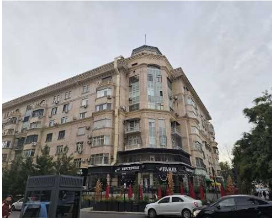
1 階を店舗として改築した集合住宅 街中ではこのような建物が散見される
