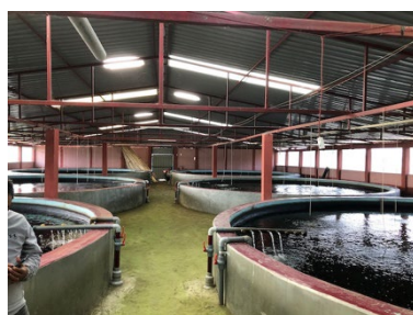
閉鎖循環式養殖システム
