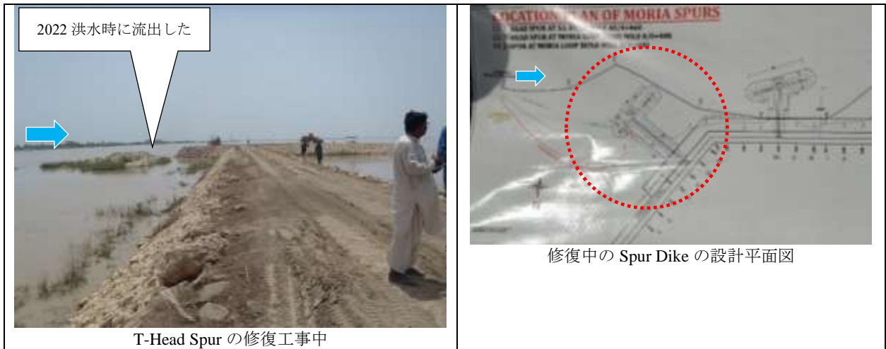
写真 1.1.5 Moria Loop Bund で修復工事中の T-Head Spur Dike (2023 年 8 月 3 日)
