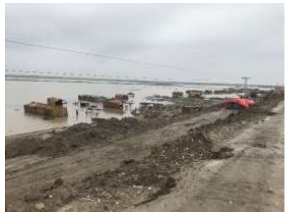
写真 4.2.2 MCB の堤内側の状況
