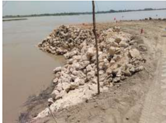
写真 3.2.5 既設水制工の状況 (Moria Loop Bund)
