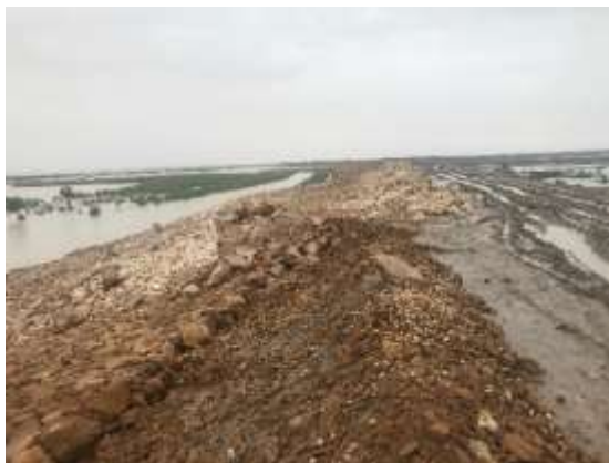
写真 4.2.1 MCB の天端及び湖側の状況
