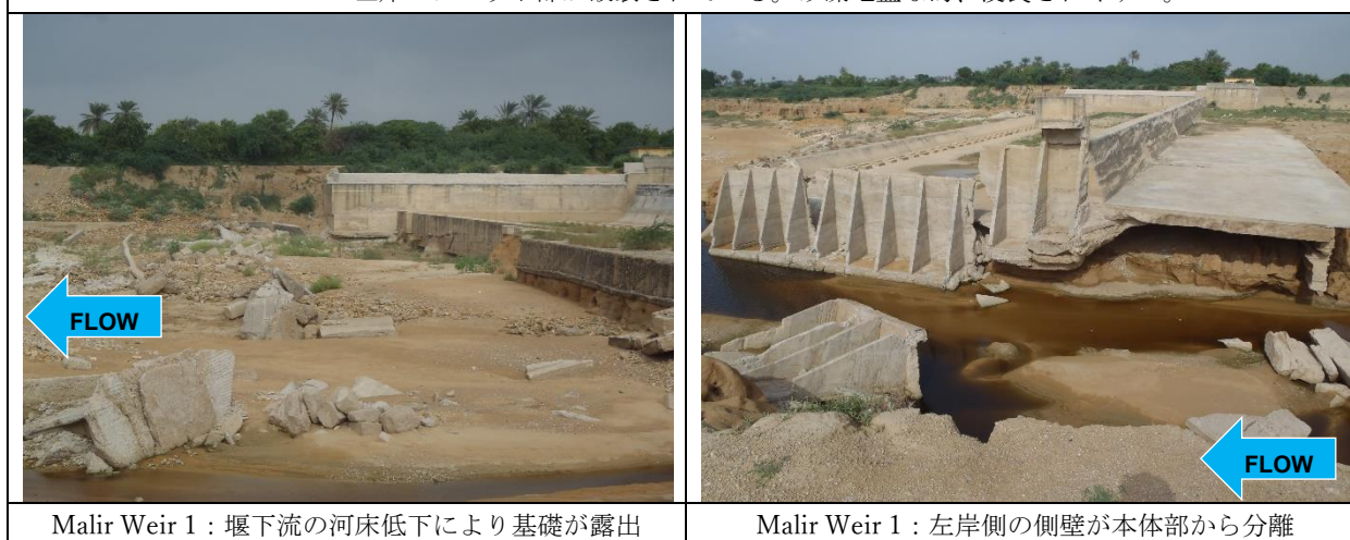
Malir Weir 1 : 左岸のアバット部が破壊されている。砂礫地盤な為、浸食されやすい。
