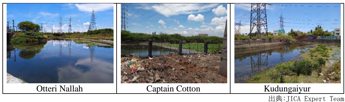
Figure 3-4: 北 Buckingham 運河に接続する水路
