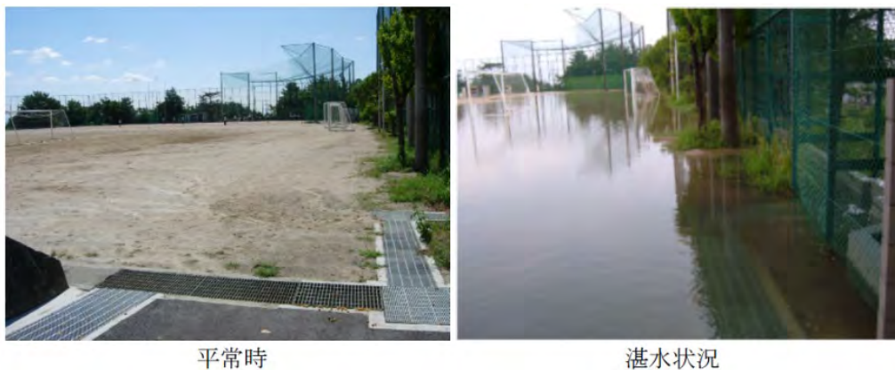
Figure 4-49: 校庭貯留の平常時と貯水時の状況
