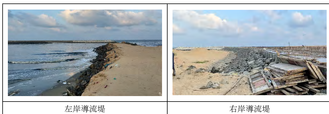
Figure 5-65: Cooum 河口導流堤 (2024/2/13 撮影)
