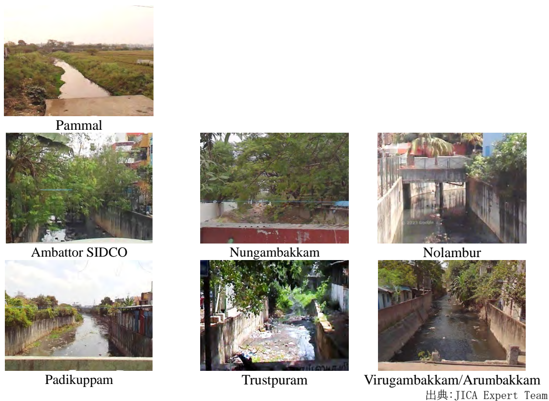
Figure 3-3: Adyar 川および Cooum 川に接続する水路の状況
