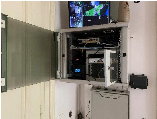
写真-15：既存のインターネット接続スイッチャー（BHテレコムから借りている）
