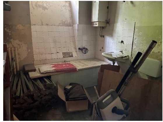
写真-12：サーバールームが設置される予定の部屋（管理パビリオン地下階、改修が必要）
