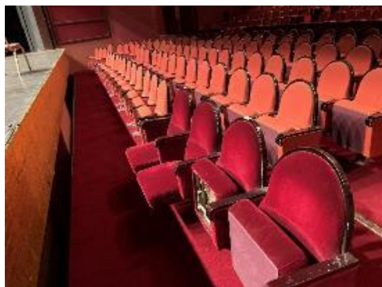
写真-10:座席の裏面が一部損傷している既存座席
