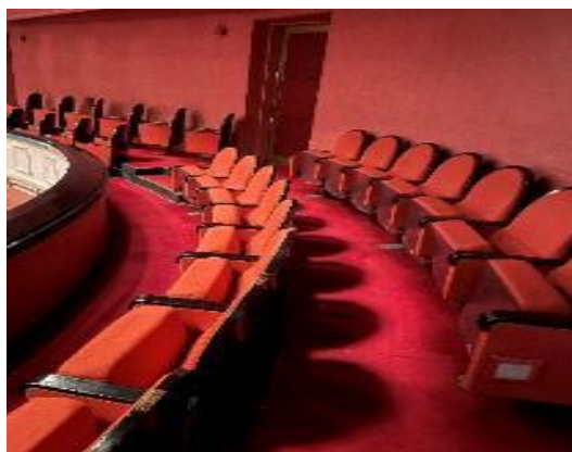
写真-9:大ホールの2階席の既存座席と既存カーペットの設置状況
