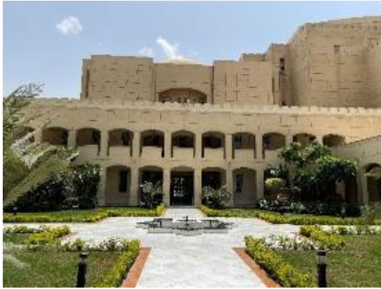
写真-1: 国立文化センター外観
