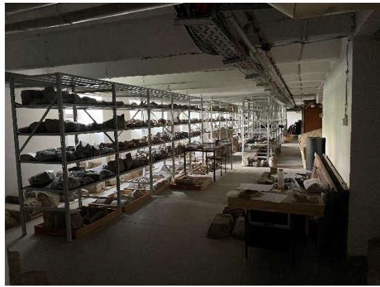
写真-13：考古パビリオン地下階収蔵庫（光ファイバーケーブル設置予定場所）
